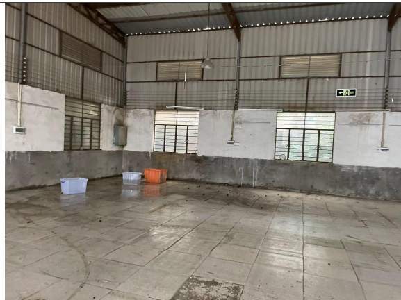
项目厂房现状
