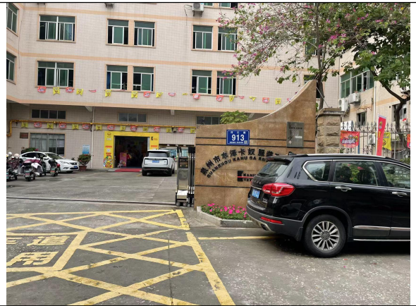
项目北侧 泉州市丰泽卡奴服装有限公司
