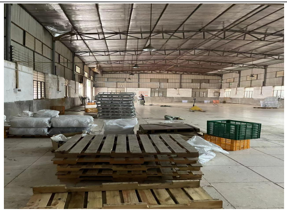
项目厂房现状
