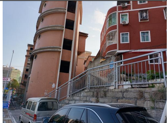
项目南侧：商住楼
