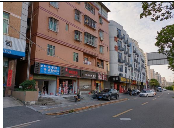
项目北侧：商住楼
